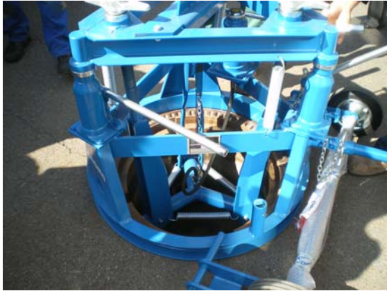
Anheben des Schachtrahmens mittels Hebegerät – hier HS 30
