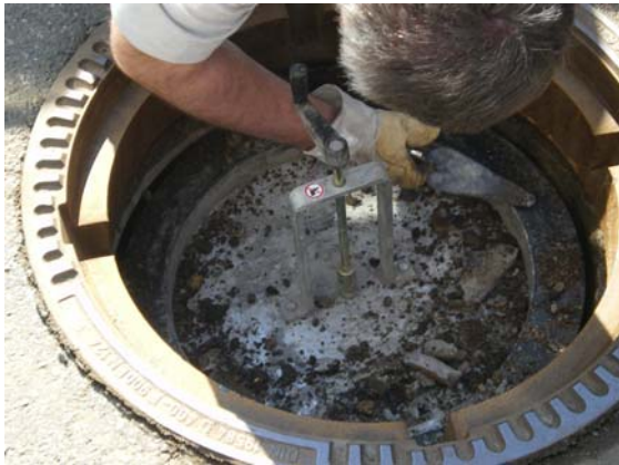
Einsetzen der Schachtabsperrplatte und reinigen der Fuge
