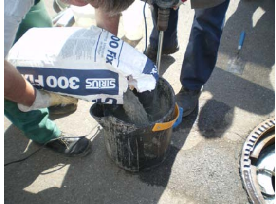
SIRIUS 300 Fix in das vorgelegte Wasser geben und in dem Gießeimer mittels Bohrmaschine + Quirl mischen.
