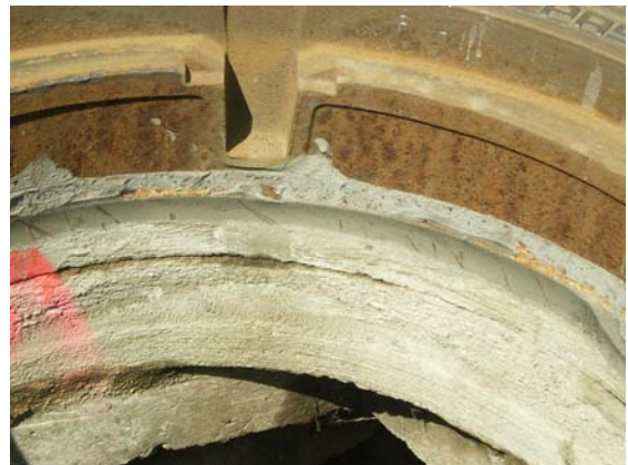
Fertig gefüllte Fuge.
