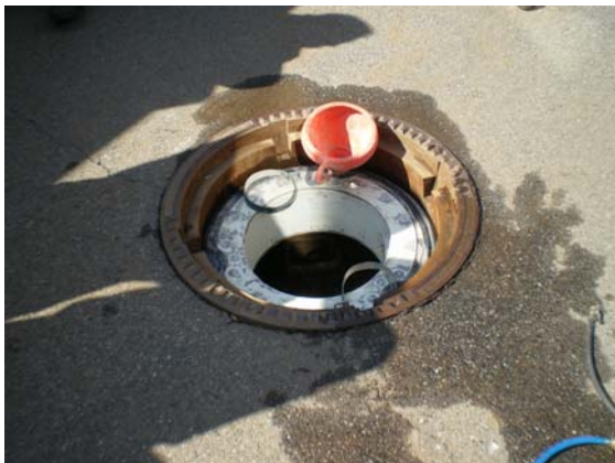
Schlauchschalung – hier Type KSR, mit Einfüll- und Entlüftungsrohr, sowie Trichter einsetzen. Fülldruck max. 0,3 bar
